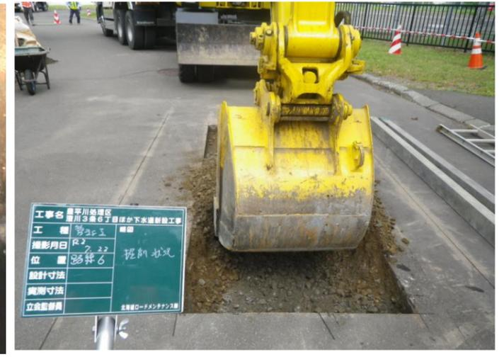
【道路から約3.40mにある古い管を土留をして掘り、新しい鉄筋コンクリート管に入れ替えました】
