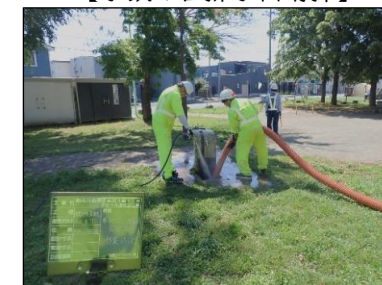
【水飲み台排水桝清掃】
