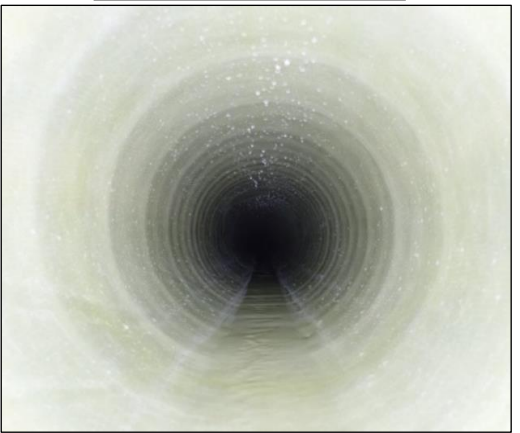
管更生した管（施工後）
