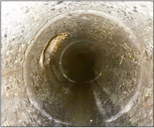
老朽化した管（施工前）
