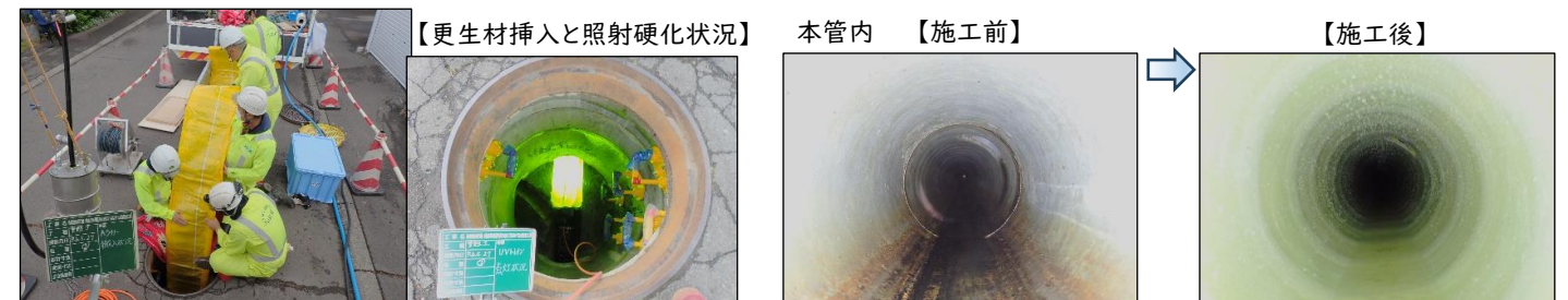
取付管 管口仕上げ
