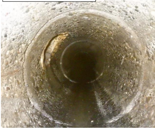
老朽化した管（施工前）
