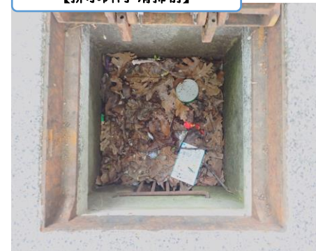
【排水樹内 清掃前】
