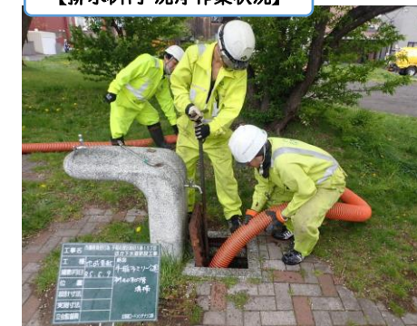
【排水樹内 洗浄作業状況】
