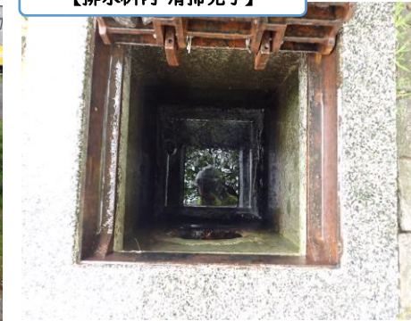
【排水樹内 清掃完了】
