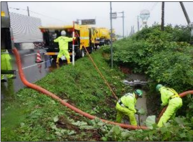
管渠清掃工事
